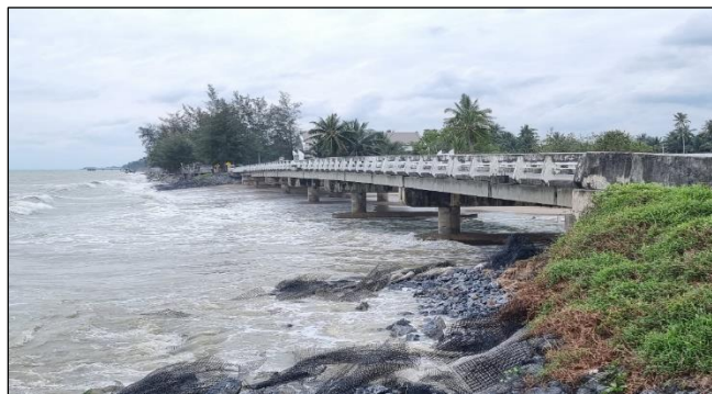
รูปที่ 7.2-2 รูปแบบแบบโครงสร้างสะพาน และตัวอย่างสะพาน กรณีเป็นร่องน้ำที่ไม่มีเรือสัญจรผ่าน
